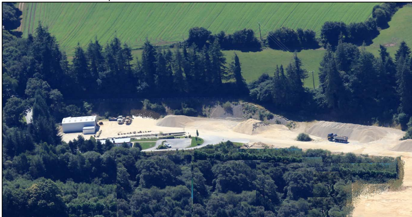
Plateforme de matériaux après remise en état.
